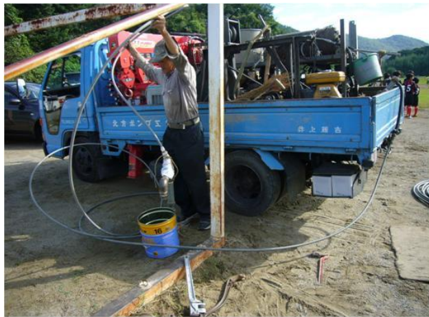
③3m地点停滞位置で、サクシオン 清掃用ホース貫入作業 圧カレベル上昇させて掘削
