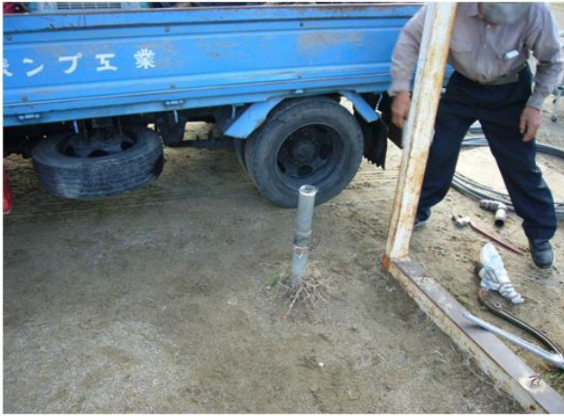
工事名 堂後G既設井戸復旧工事 ①既設手動式ポンプ解体
