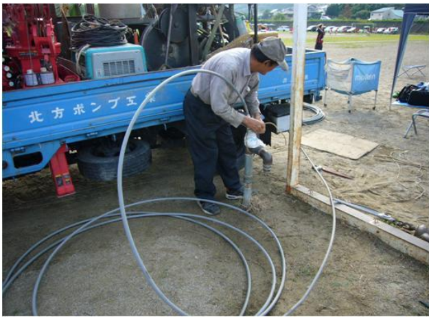
②圧搾空気送出ホース挿入 (5m～最深部10m)
