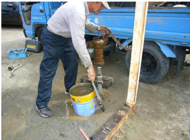
⑨既設手動式ポンプ再設置
